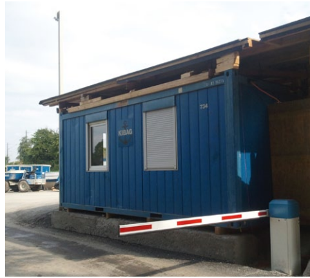
Eingangssituation mit Schranke
